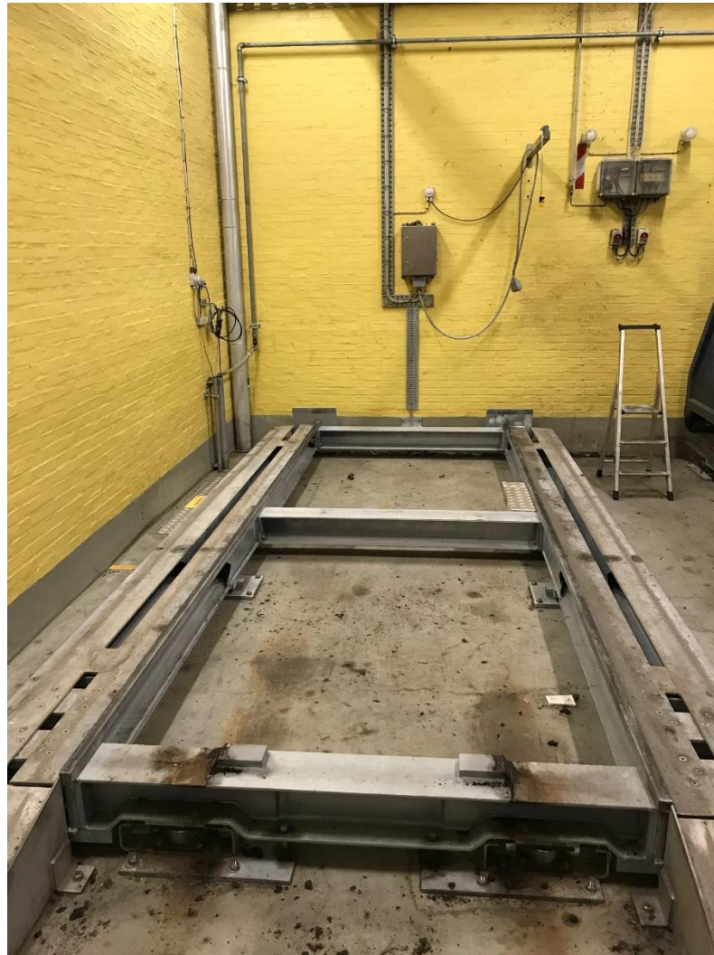
Figur 1: Tre af fire slamcontainerne på RAV står på vejebord med vejeceller.
