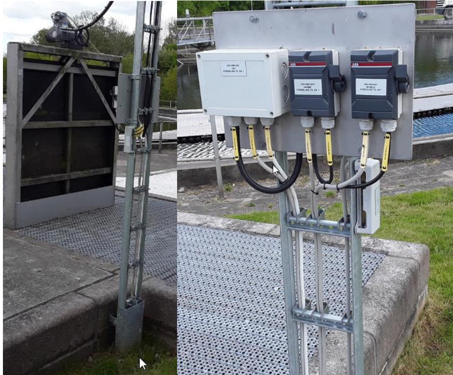
Billede 1 KS200 som stander for maskininstallation
